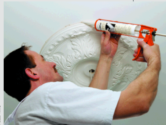
Montage eine Fertig-Rosette. Aus Polystyrol kostet das Stück etwa 30 Euro
