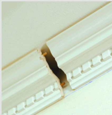
Die fertigen Elemente werden einfach zusammengesteckt und an die Decke geklebt
